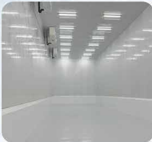
Cámaras industriales frigoríficas
