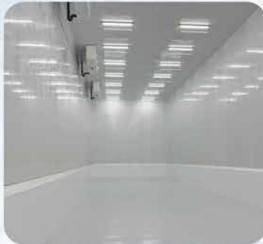
Cámaras industriales frigoríficas
