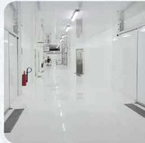
Pasillos de antecámaras
