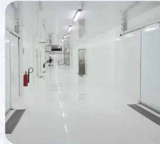
Pasillos de antecámaras
