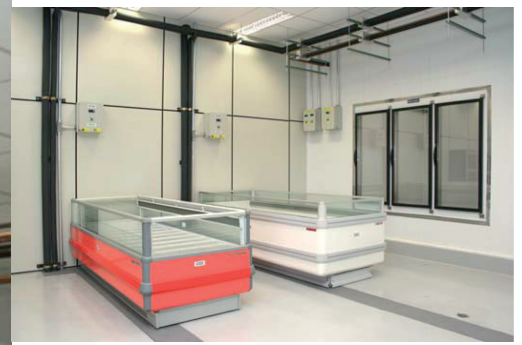
Figura 02: Detalle de las islas y cámara frigorífica (walk-in cooler).
