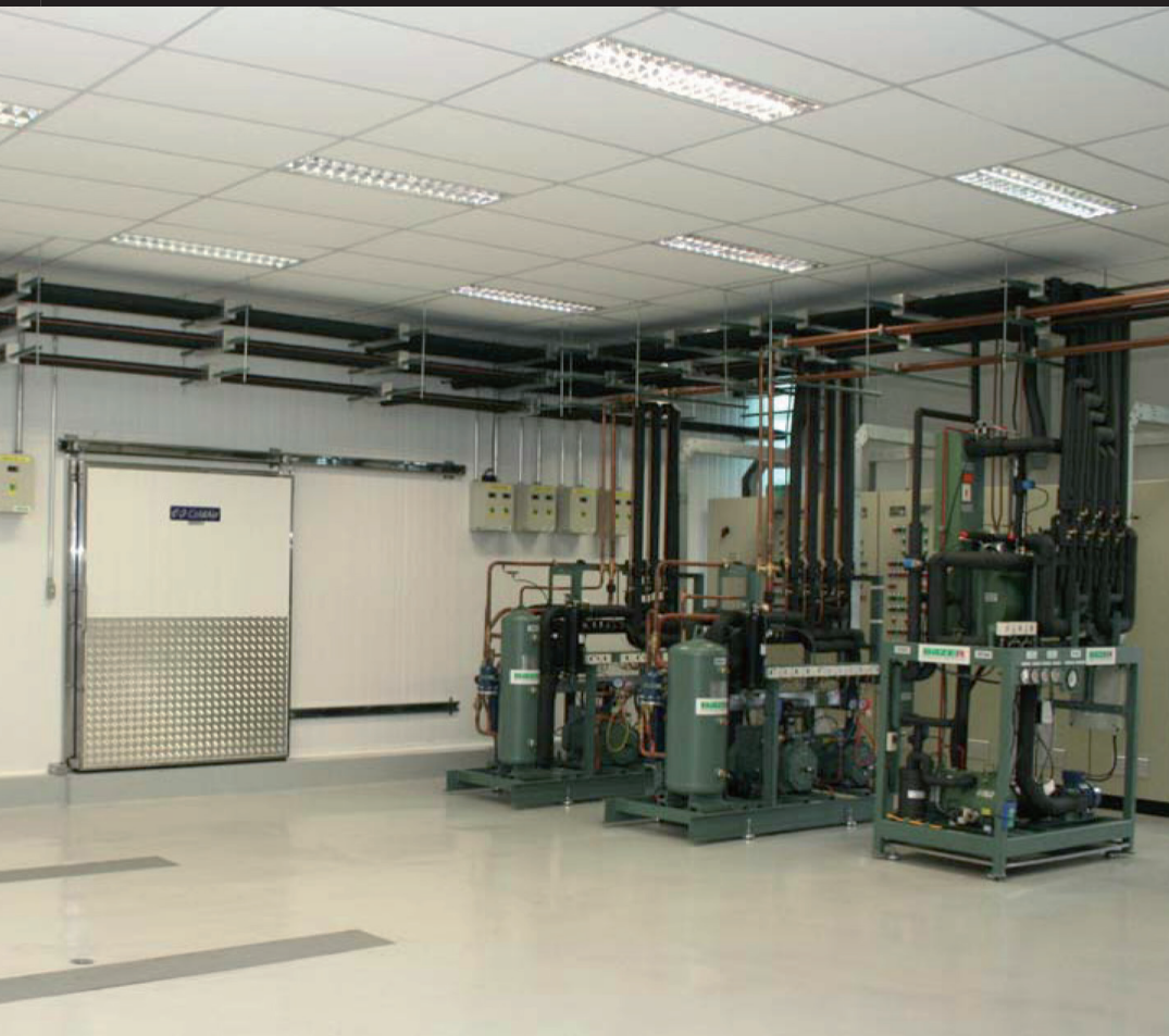
Figura 02: Detalle de las islas y cámara frigorífica (walk-in cooler).
