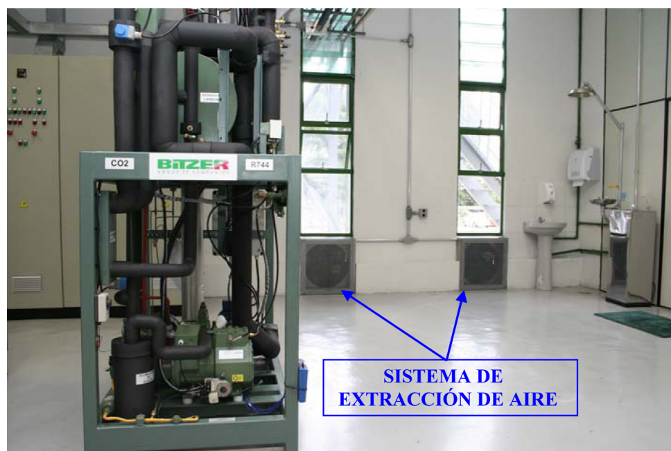
Figura 15: Detalle del sistema de extracción de aire y alarma utilizada en caso de fugas de CO2
